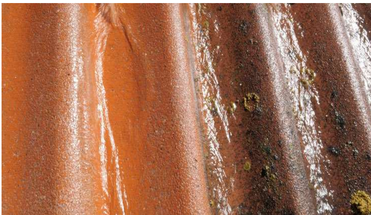
Slika 31. Površina očišćena Aqua Jet-om [17]
