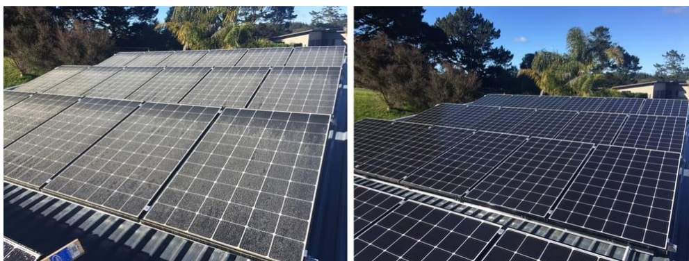
Slika 1.6. Prljave i očišćene solarne ploče [20]
