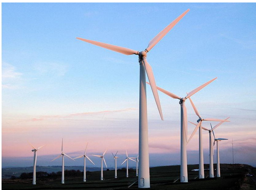
Slika 18. Kopnena vjetroelektrana Royd Moore, UK
